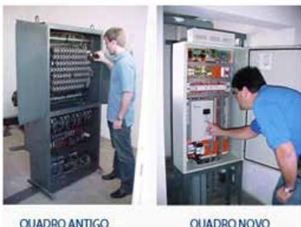
Exemplo de substituição de sistema de controle antigo por moderno com microprocessador
